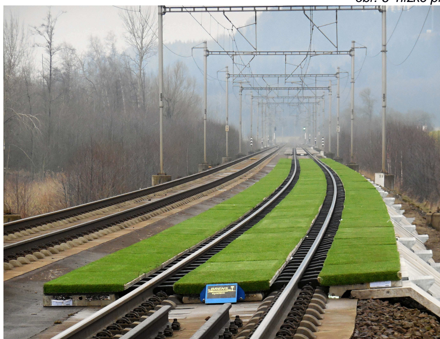
obr. 7 kolejové absorbéry hluku
